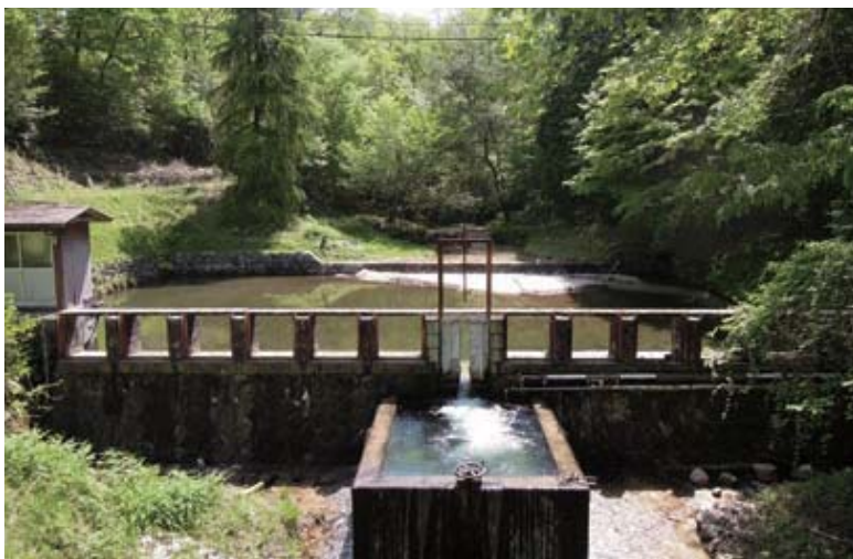
現在の白坂量水堰堤
