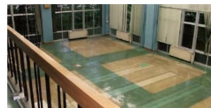
改修前(左)と改修後(右)の参考図書コーナー。改修前は全面ガラス張りの吹き抜け空間であり、強度の弱い一画だった。改修後は、厚さ40cmの耐震壁に幅50cm、高さ290cmのスリット窓を設けることで、強度を保ちつつも、穏やかな空間となった。まさに安全性と居住性のせめぎ合いの中で生まれた空間である。
