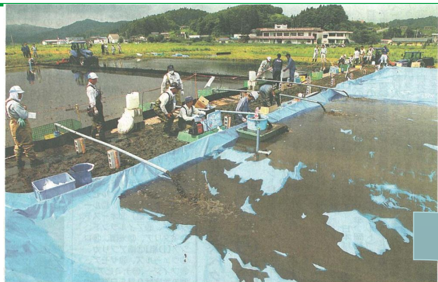
トラクターで代かきした水田(左)から泥水を排水し、放射性物質を除去する実験＝福島県飯館村で8月24日、森田剛史撮影
