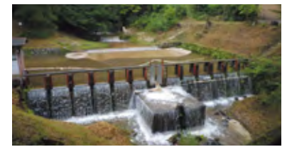
山地河川から流れ出る水の量をモニタリングする白坂量水堰(増水時の様子)
