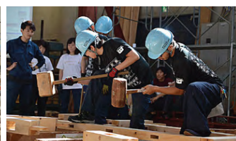
学生も大工さながら施工を行う。
