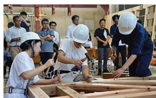
耐力壁の解体中の風景。 女性も参加して手際よく行っている。
